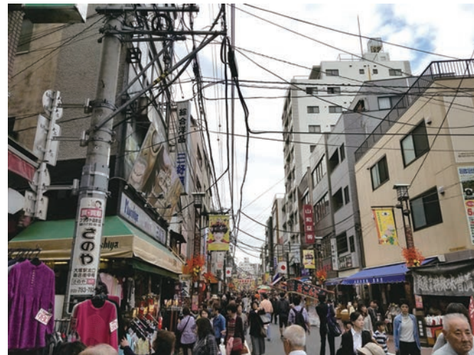
巣鴨地蔵通り電柱の現状
