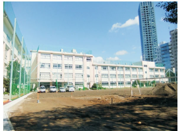
今年校庭の改良工事を行った千川中学校
